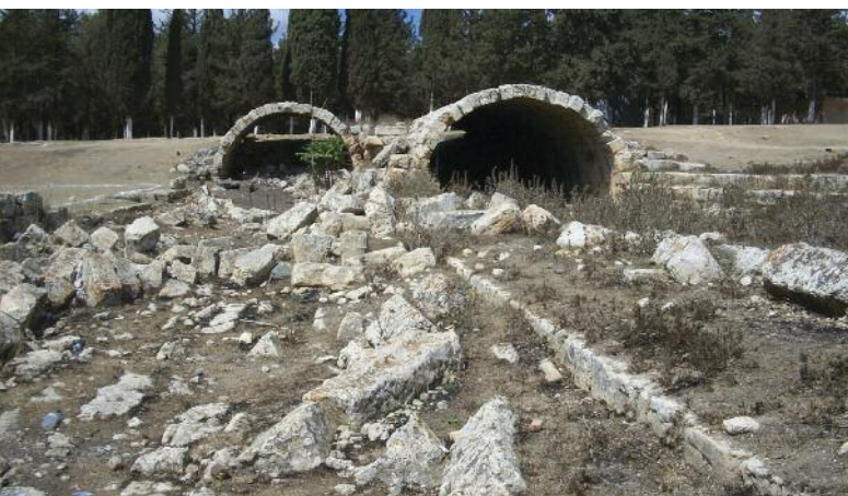
Le coperture voltate conservate dei serbatoi terminali dell'acquedotto di Cirene
