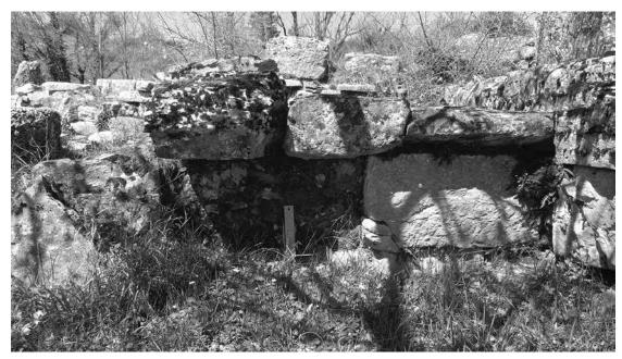
Fig. 7 - Muro divisorio tra pronao e cella, tratto E: risarcitura sommaria realizzata con lastre di arenaria (foto Autore)
