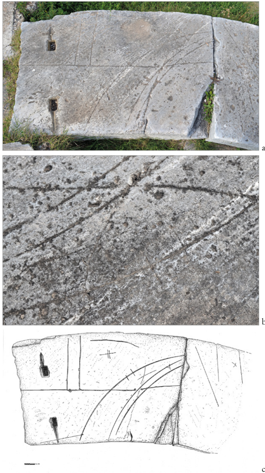
Fig. 9. Atene. Biblioteca di Adriano, ambulacro settentrionale della basilica di Eudocia; a) lastra dello stilobate con tracciato di cantiere per realizzazione di elemento curvo; b) particolare; c) resa grafica delle incisioni sulla lastra (foto A.).
