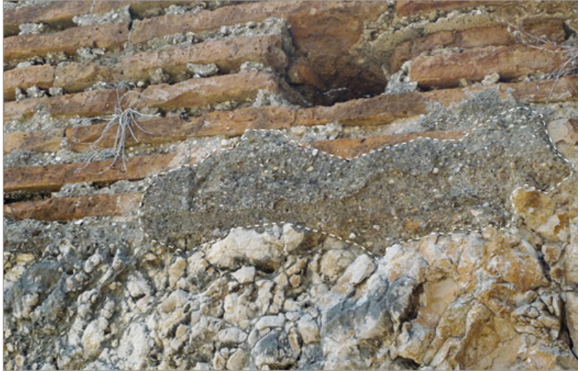
Fig. 14. Tracce di intonaco sul paramento interno del muro S della vasca B.
