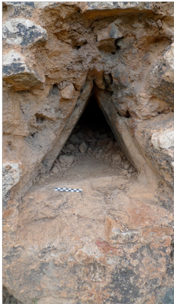
Fig. 6. Apertura triangolare formata da tre mattoni sesquipedali inglobati nella muratura in conglomerato.
