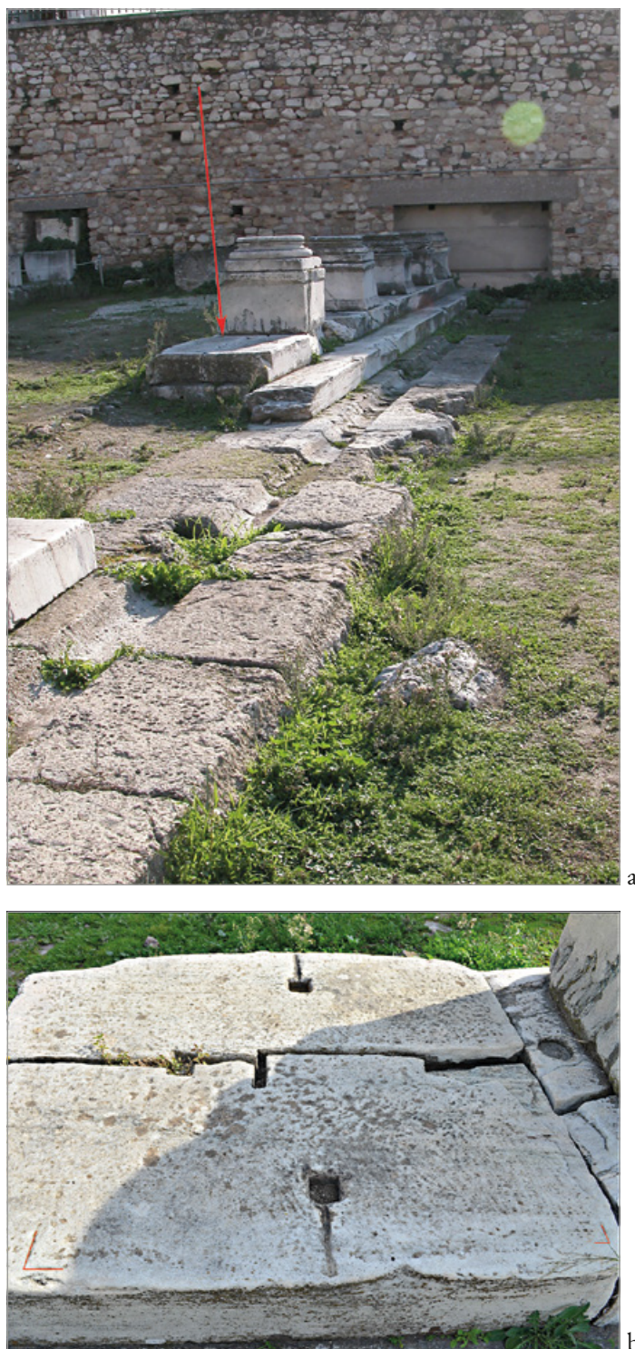
Fig. 4. Atene. Biblioteca di Adriano, portico occidentale; a) posizione di una delle lastre dello stilobate con tracciati di cantiere angolari; b) lastra dello stilobate con incisi gli angoli per il posizionamento di oggetto a base quadrata (foto A.).
