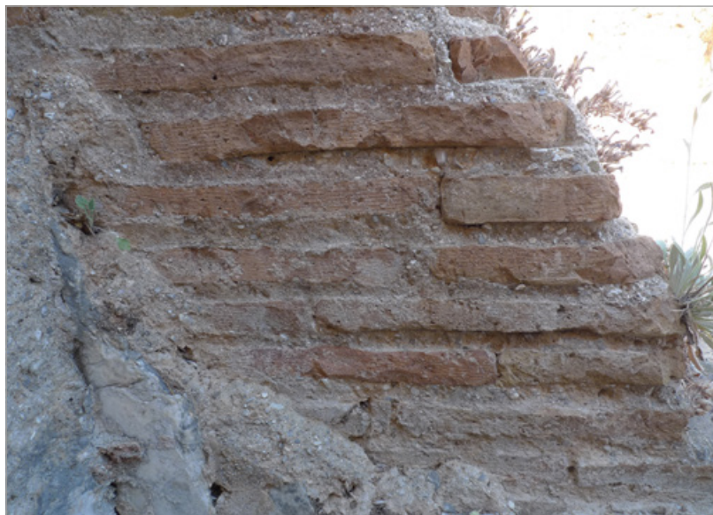
Fig. 8. Segni sulla superficie dei laterizi (paramento laterale della scala che collegava la vasca A alla vasca B della mostra dell'acqua). Si notino i resti del rivestimento marmoreo.
