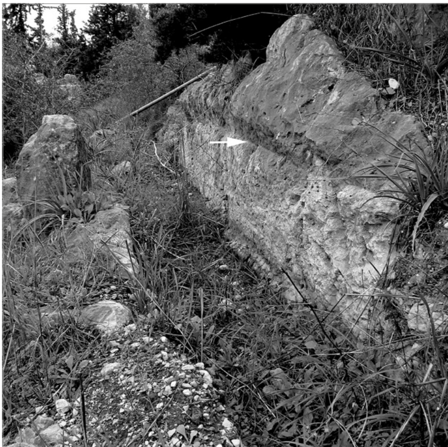
Fig. 3. Tratto dello specus dell'acquedotto scavato nella roccia. La freccia indica il punto in cui iniziava la copertura "a cappuccina".
