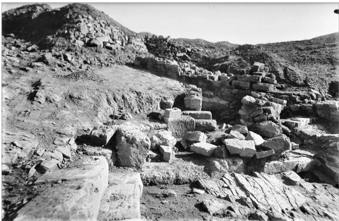
Fig. 4. L'esedra in corso di scavo (1938).
